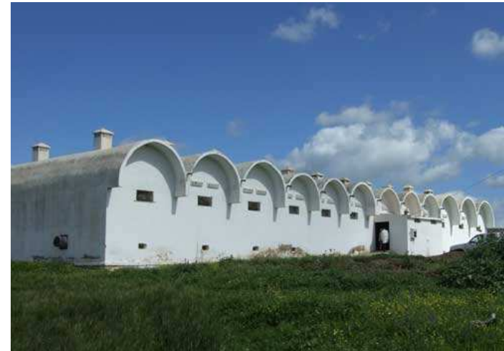
Bâtiment fermé=> contrôle de la ventilation
